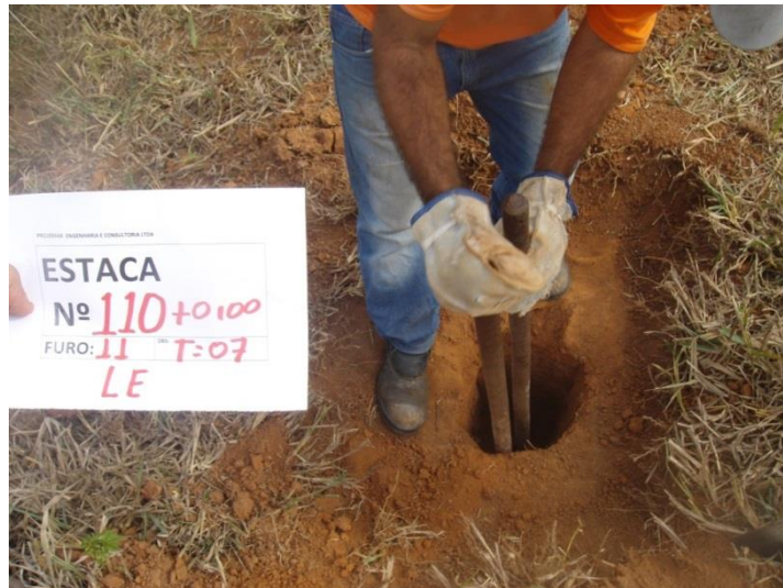
Figura 01: Solo de silte-arenoso de boa compactidade, sem presença de nível d'água.
