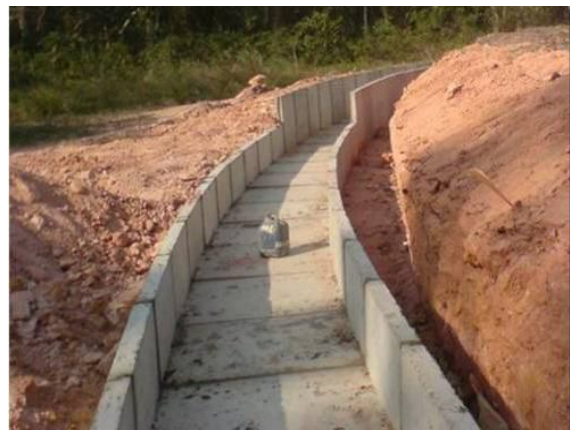
CANALETELA DE PROTEÇÃO DE TALUDES.
