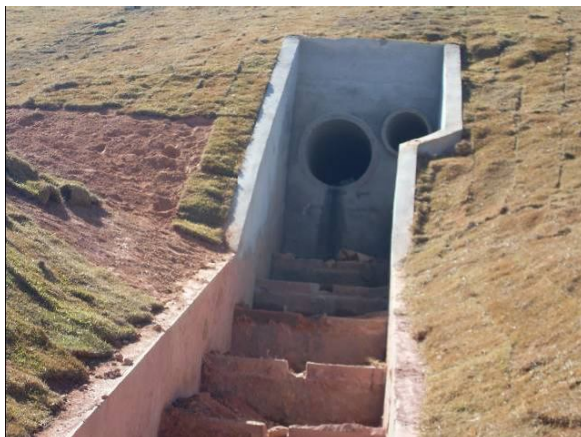
ESCADA D'ÁGUA OU DISSIPADORES DE ENERGIA.
