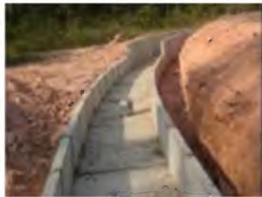
CANALETA DE PROTEÇÃO DE TALUDES.
