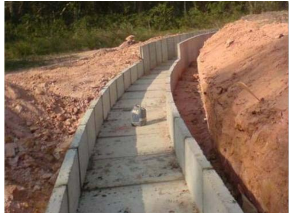
CANALETA DE PROTEÇÃO DE TALUDES.
