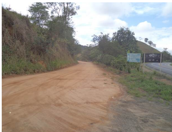
INÍCIO DO TRECHO 3.2 CAJU – CANCELA – MONTE BELO
