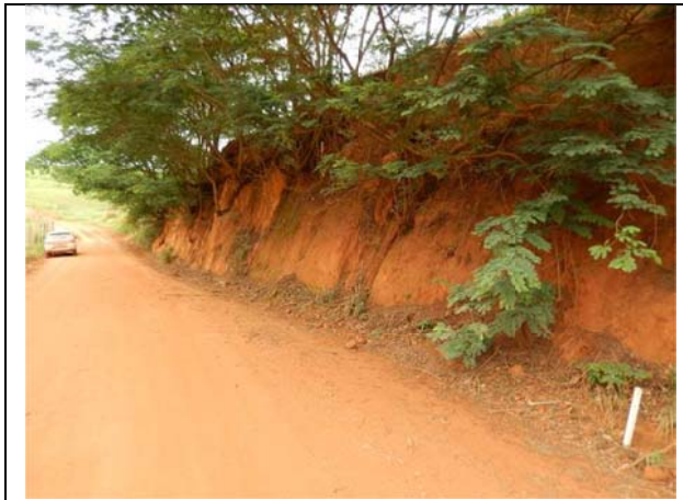
Talude de corte sem cobertura vegetal.
