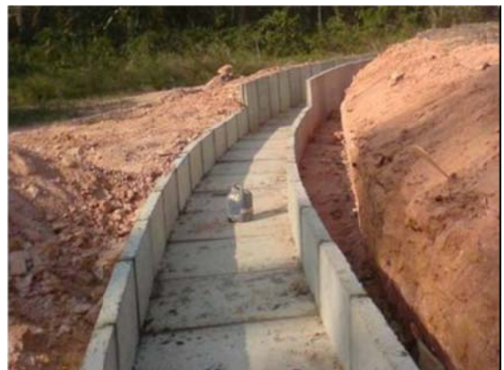
CANALETA DE PROTEÇÃO DE TALUDES.
