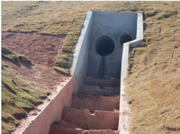
ESCADA D'ÁGUA OU DISSIPADORES DE ENERGIA.
