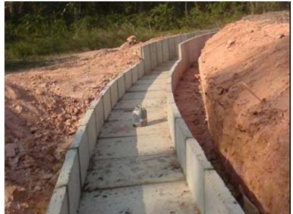
CANALETA DE PROTEÇÃO DE TALUDES.
