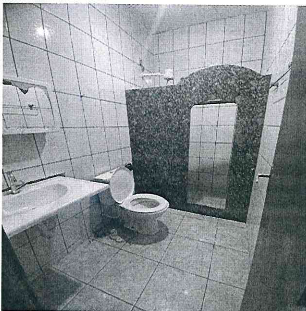
Banheiro 02 com revestimento cerâmico até ao teto.
