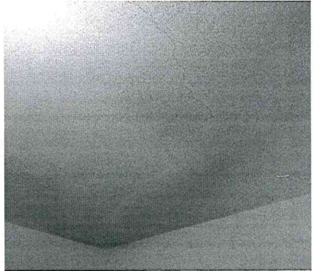
Área de serviço e cozinha com trinca no teto.
