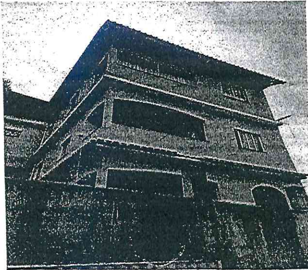
Fachada frontal, 1º pavimento.
