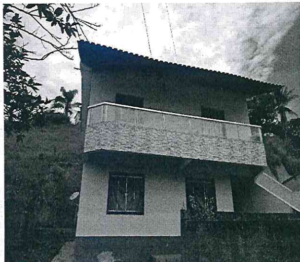
Fachada frontal, pavimento térreo.
