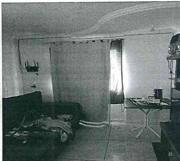
Sala com teto rebaixado em Gesso.
