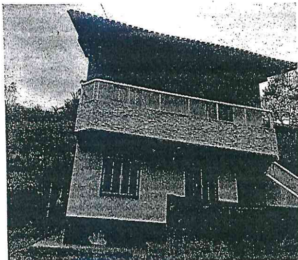
Fachada frontal, pavimento térreo.
