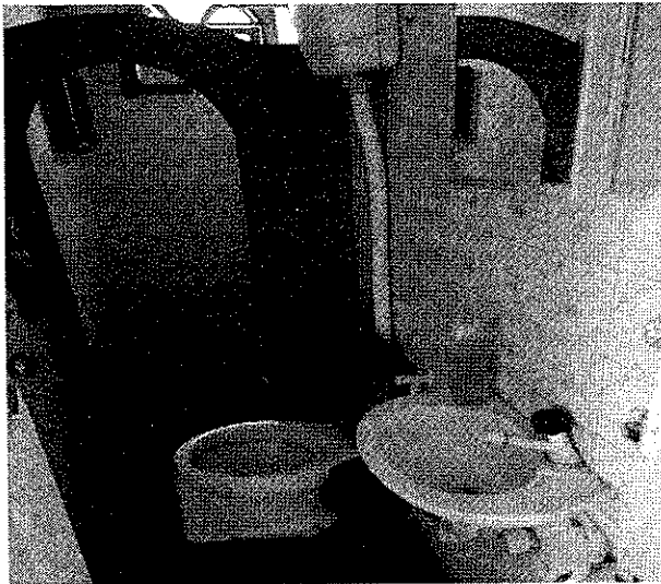
Banheiro com marcas de infiltração na parede.
