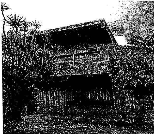
Fachada frontal, pavimento térreo.
