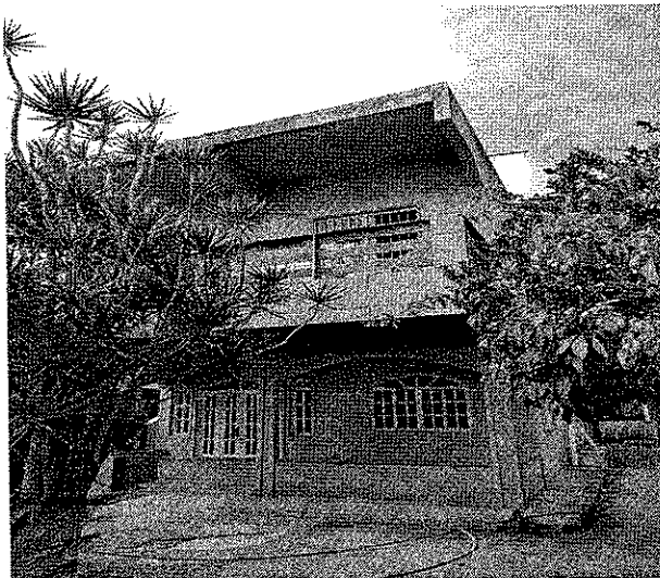
Fachada frontal, pavimento térreo.
