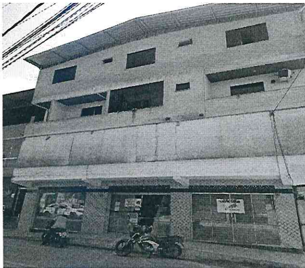
Fachada Frontal do imóvel, 2º Pav.
