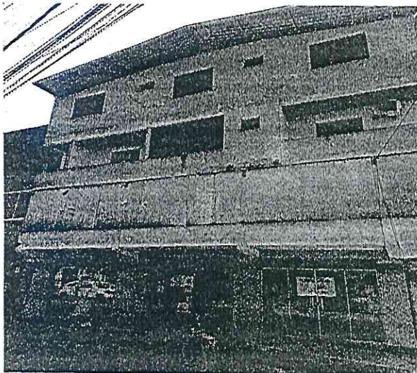
Fachada Frontal do imóvel, 2º Pav.
