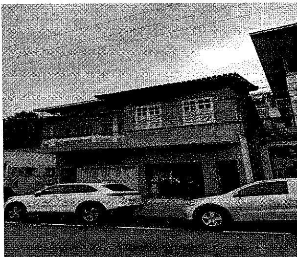
Fachada do imóvel, 1º pavimento.
