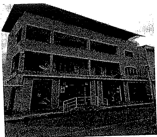
Fachada do Imóvel, 2º Pavimento.
