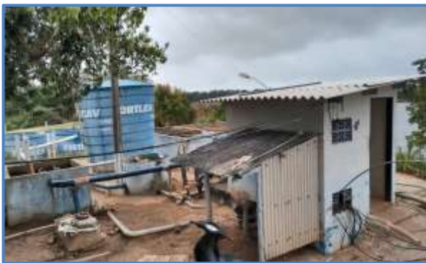
A. Captação de água
