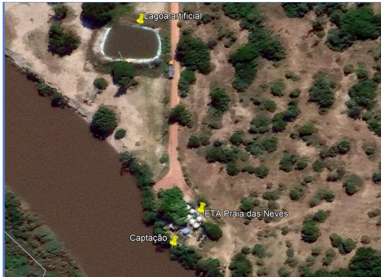
Foto 01 – Vista geral das principais unidades do SAA Praia das Neves.
