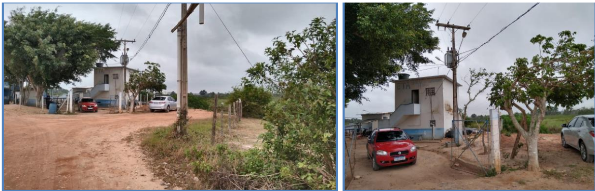
Foto 03 - ETA existente no município, localizada em Praia das Neves
