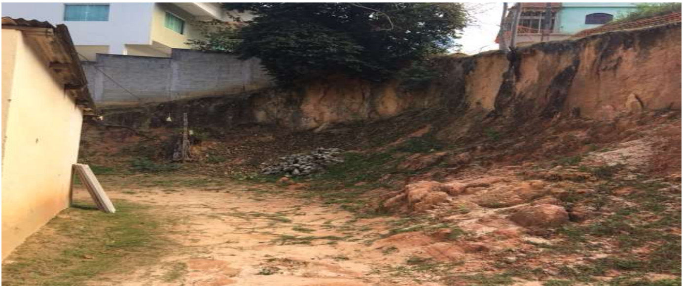
Foto 2 – Vista geral do acidente
