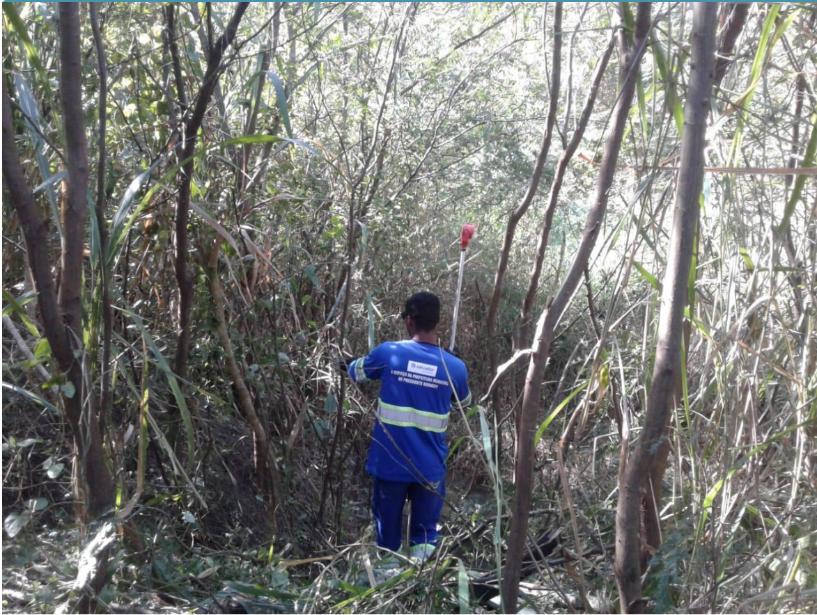
Foto 05 – Levantamento topográfico do caminhamento da linha de emissário de esgoto tratado, realizado pela equipe de topografia da TRANSMAR
