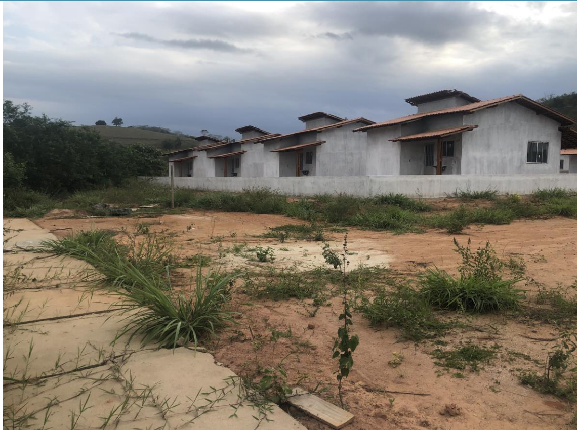
Foto 02 – Vista lateral do terreno onde será instalada a ETE na localidade de São Paulo
