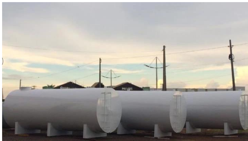
Imagem 05: Modelo de caixa tanque para armazenamento de efluente.
