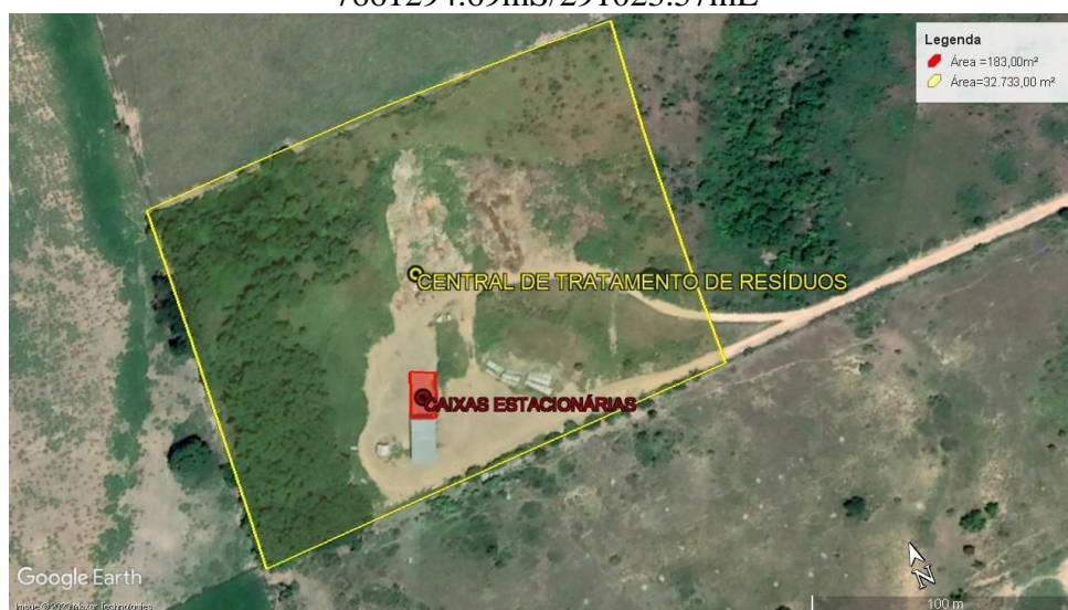
Imagem 02: Área da CTR e localização das caixas tanque de armazenamento dos resíduos. Google Earth: Datum WGS84
