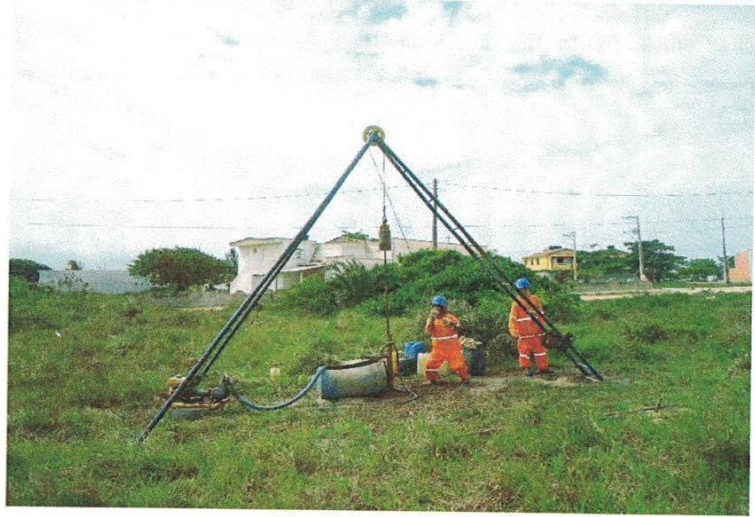
Execução do Furo SP 02:
