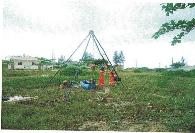
Execução do Furo SP01
