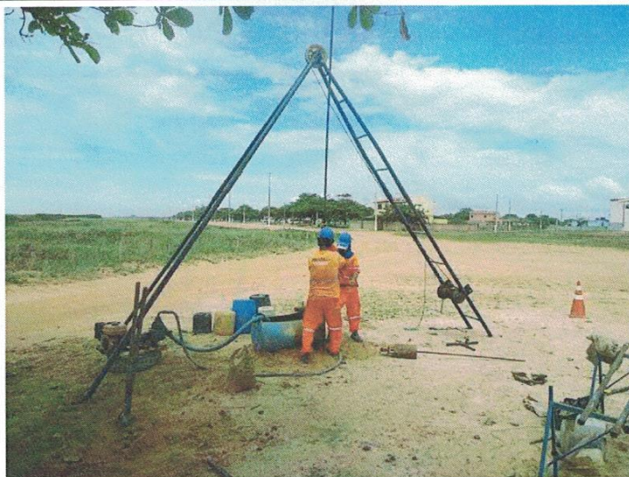
Execução do Furo SP 02:
