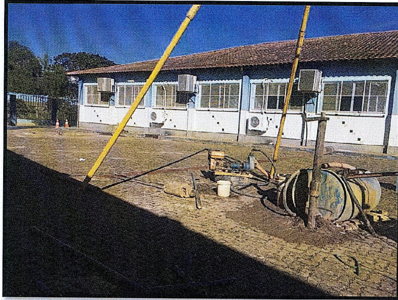
FOTO 01 – EXECUÇÃO DA SONDAGEM SP-01
