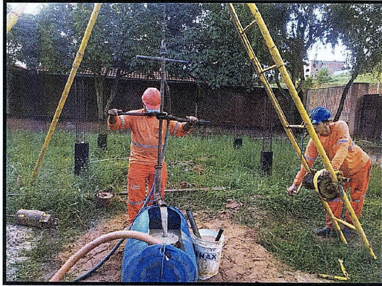
FOTO 03 – EXECUÇÃO DA SONDAGEM SP-02
