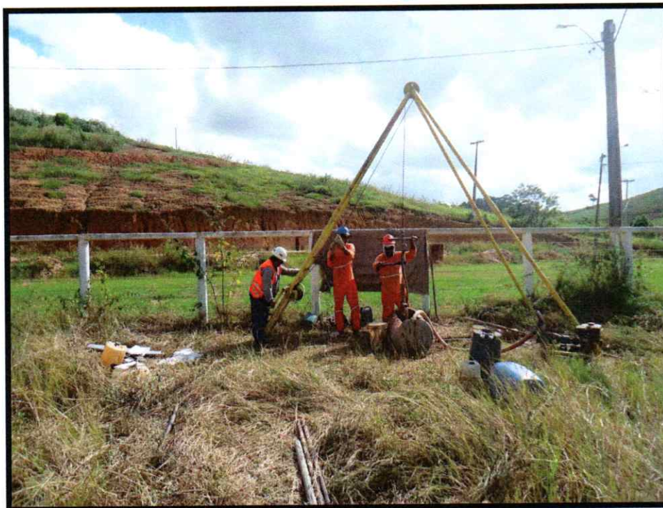
FOTO 07 – EXECUÇÃO DA SONDAGEM SP-04
