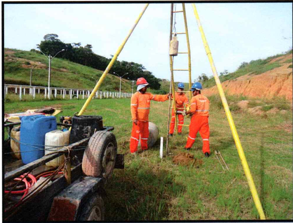
FOTO 09 – EXECUÇÃO DA SONDAEM SP-05
