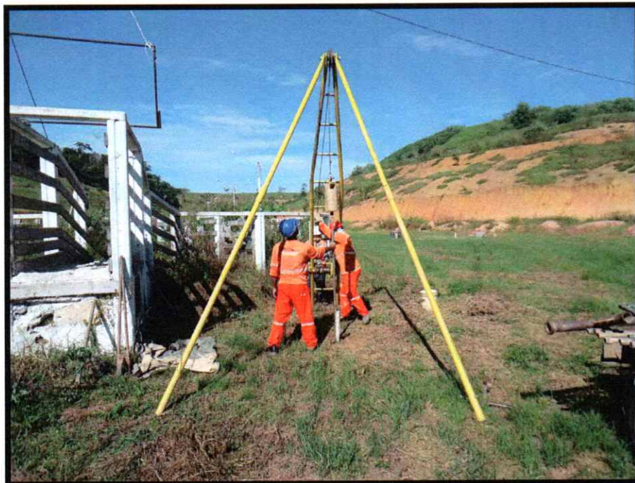
FOTO 05 – EXECUÇÃO DA SONDAGEM SP-03
