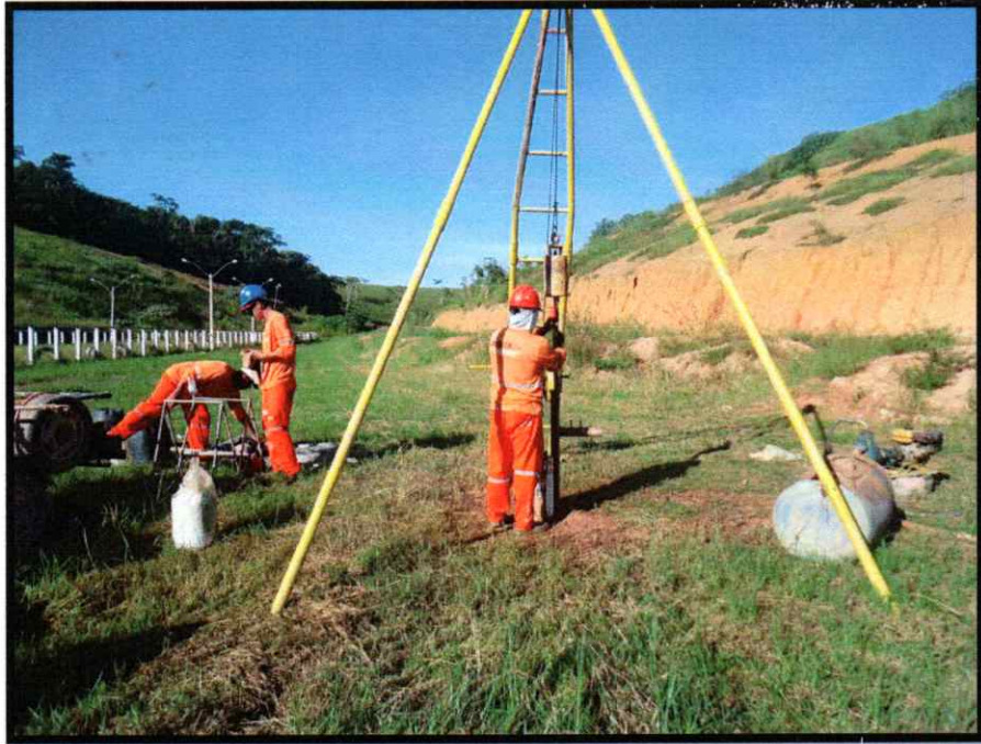
FOTO 01 – EXECUÇÃO DA SONDAGEM SP-01
