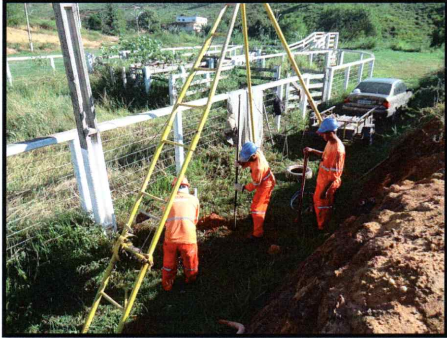
FOTO 03 – EXECUÇÃO DA SONDAGEM SP-02
