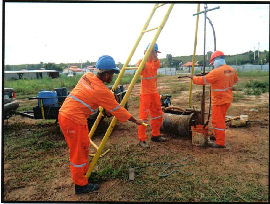
FOTO 05 – EXECUÇÃO DA SONDAGEM SP-03
