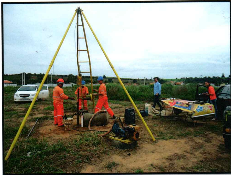
FOTO 11 – EXECUÇÃO DA SONDAGEM SP-06
