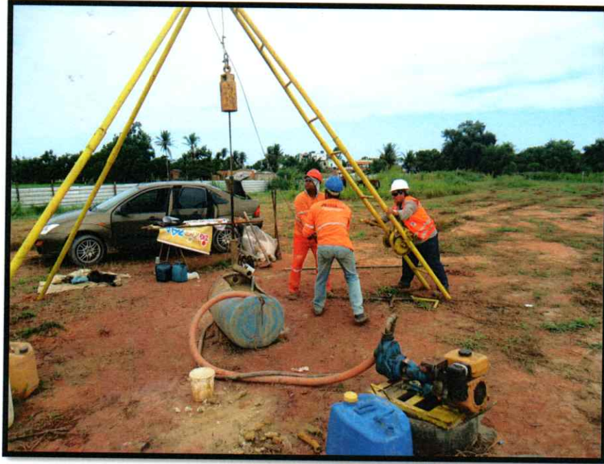
FOTO 03 – EXECUÇÃO DA SONDAGEM SP-02
