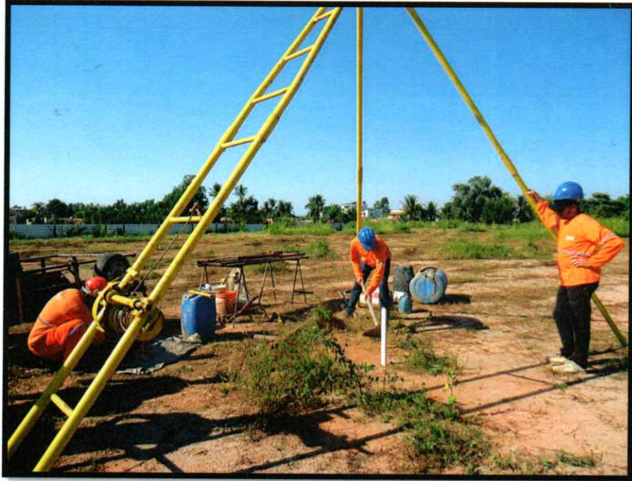
FOTO 01 – EXECUÇÃO DA SONDAGEM SP-01
