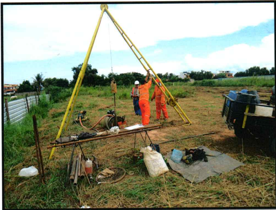
FOTO 07 – EXECUÇÃO DA SONDAGEM SP-04
