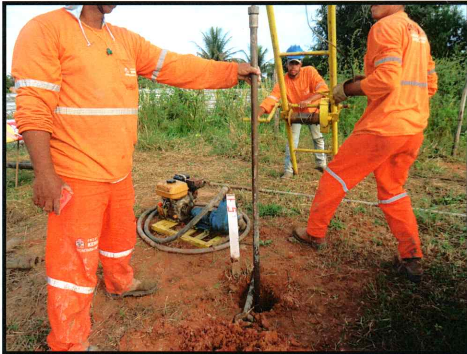
FOTO 09 – EXECUÇÃO DA SONDAGEM SP-05
