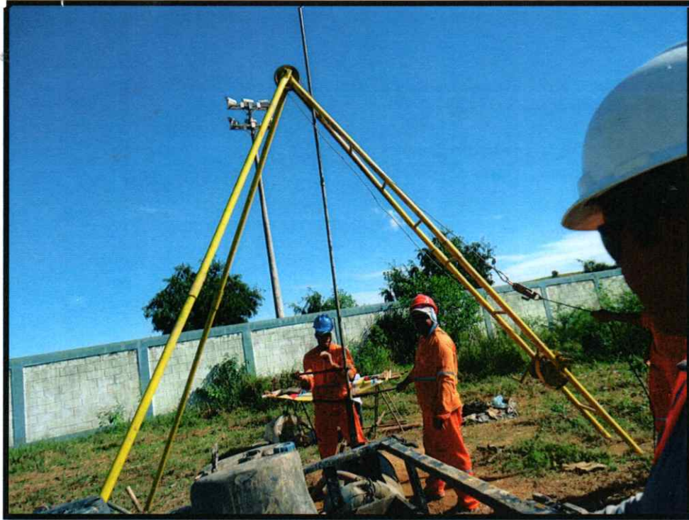
FOTO 13 – EXECUÇÃO DA SONDAGEM SP-07
