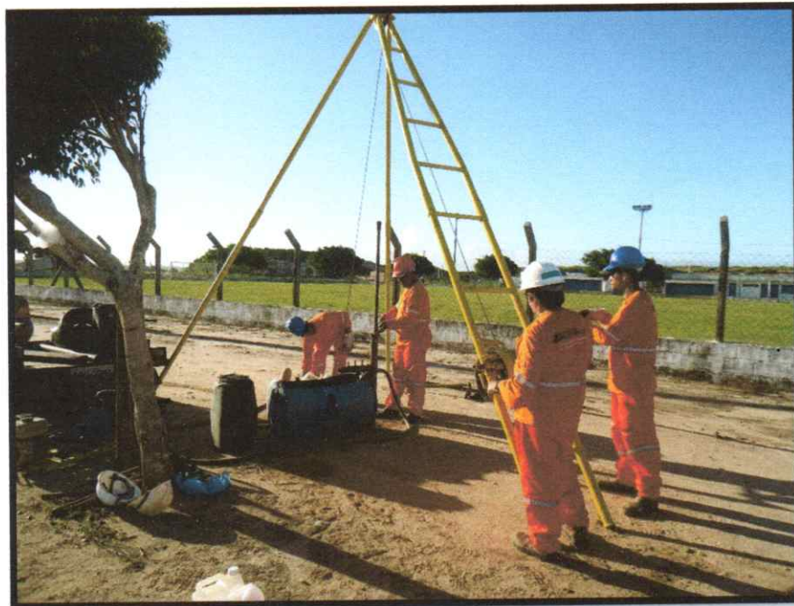
FOTO 02 – EXECUÇÃO DA SONDAGEM SP-02
